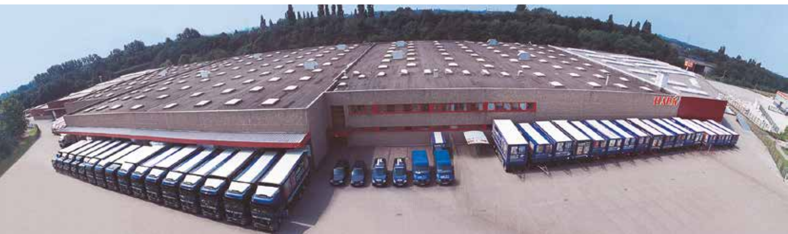
Werk 1 und Lager in Duisburg
